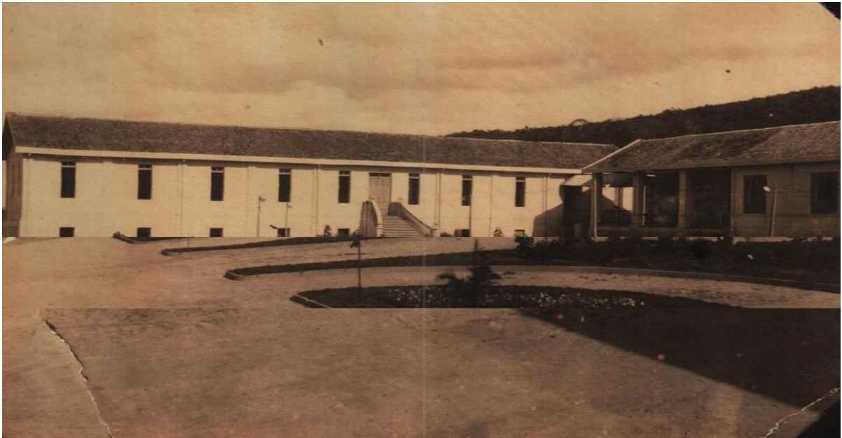
Figura 9 - Vista Parcial das instalações concluídas da Praça Central, Dormitório, Pavilhão de Aulas e Restaurante.
